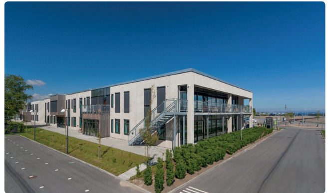
Bürogebäude in Kastrup, Dänemark
